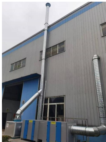
浸漆房处理设备及排气筒
