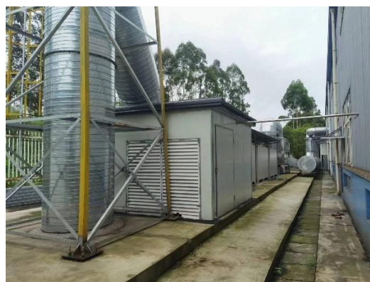
喷漆房废气处理设备
